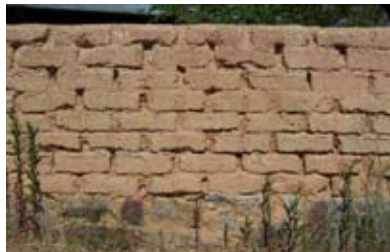
mur en adobes
