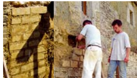
mur rebouché à l'aide de BTC stage Tiez Breiz
