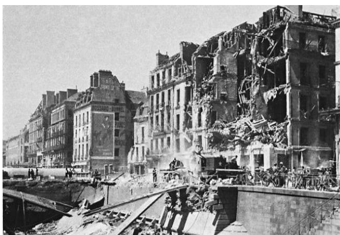
Travaux de reconstruction du quai Lamartine, août 1944 (retirage numérique). | Anonyme © Musée de Bretagne.
